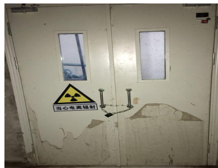
放射性固体废物暂存间上锁，设置警示标识
