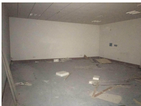
原SPECT/CT机房现状
